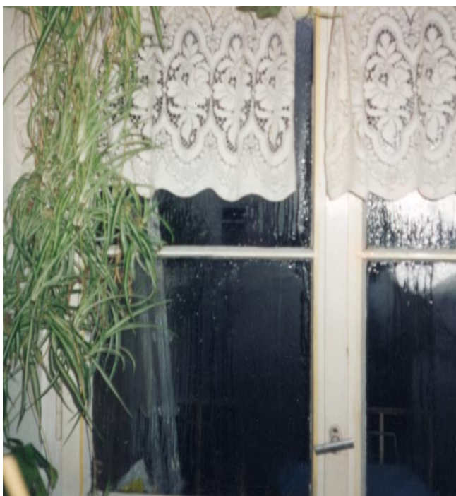
Ablaufendes Kondenswasser an einem einfach verglasten Fenster
