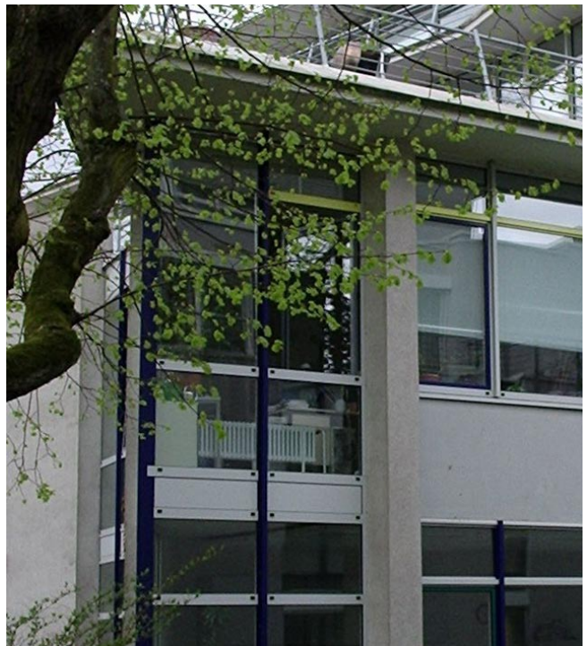
Bei diesem 1998 errichteten Bürohaus in Südhessen wurden Heizkörper ohne Abdeckung direkt vor die Verglasung gesetzt.
