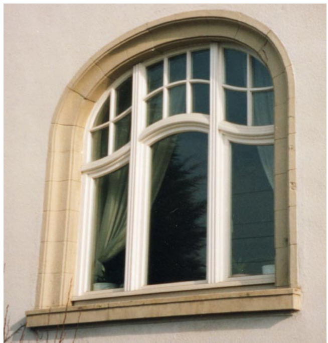
Gelungene Fenstererneuerung in einem historischen Gebäude
