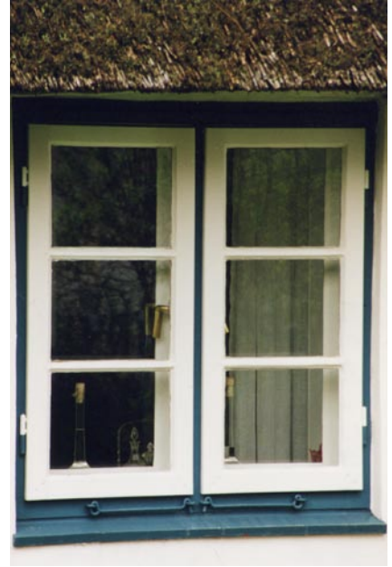
Kastenfenster in einem Haus in Norddeutschland
