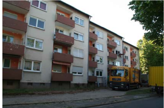
Abb. 2: Holbeinstraße vor Sanierung
