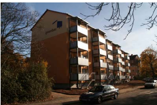
Abb. 6: Holbeinstraße nach Modernisierung
