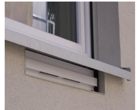
Zuluftelement einer Abluftanlage zum Einbau unterhalb der Fensterbank hinter dem Heizkörper
