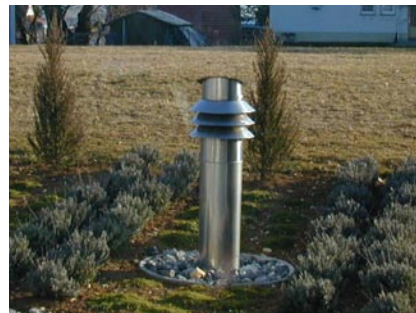
Frischluftansaugung am Ende eines Erdreichwärmetauschers
