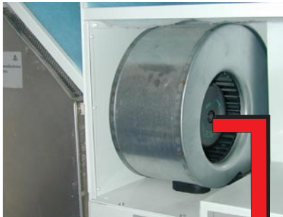
Ein Ventilator in einem Lüftungsgerät
